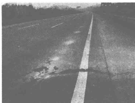
图 1.7 主轮迹带上唧浆破坏
