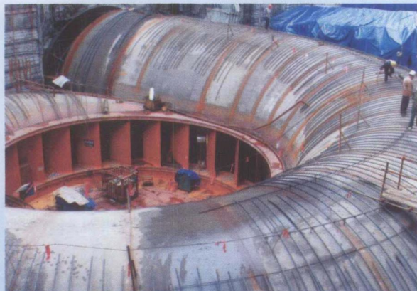
三期厂房蜗壳安装
