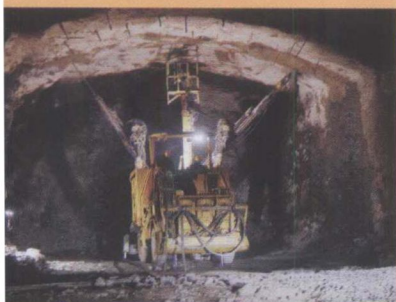
右岸导流洞多臂钻孔作业
