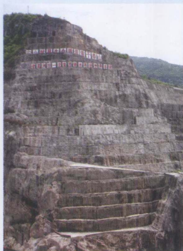
水布垭马崖高边坡整治工程
