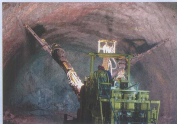
三峡地下电站洞挖精品工程
