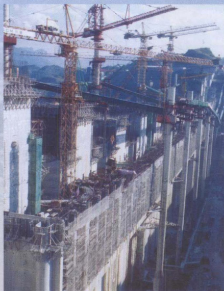
三期大坝拦污栅施工
