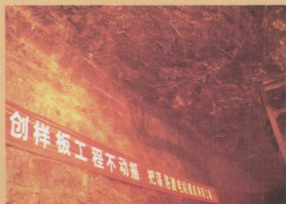
导流洞上闸室顶拱与边墙轮廓分明
