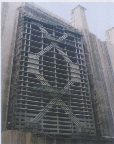
三峡闸门调试
