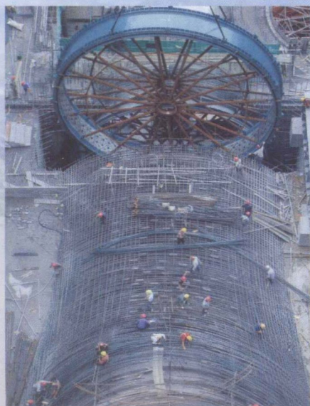
压力钢管吊装
