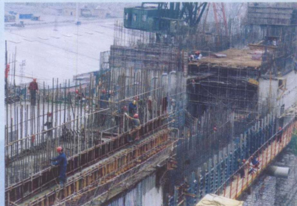
三期厂房施工
