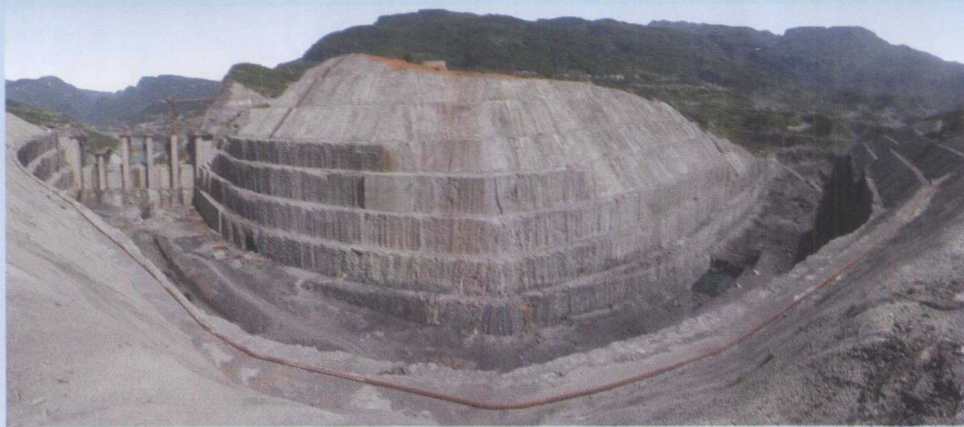
施工中的水布垭溢洪道工程
