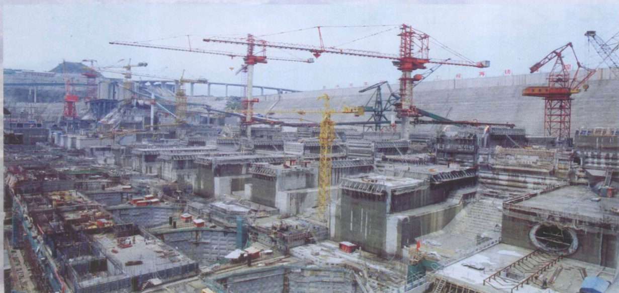
三峡三期大坝没有一条裂缝
