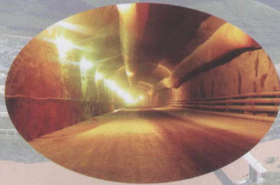
整洁明亮的施工支洞
