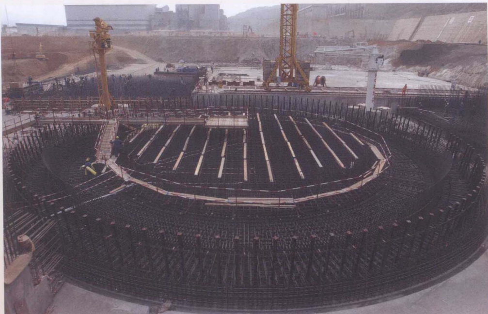
2005年11月25日，岭澳核电站二期工程1号机组核岛基础钢筋捆扎完成
