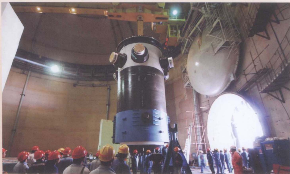
2008年10月11日，岭澳核电站二期工程1号机组反应堆压力容器安装
