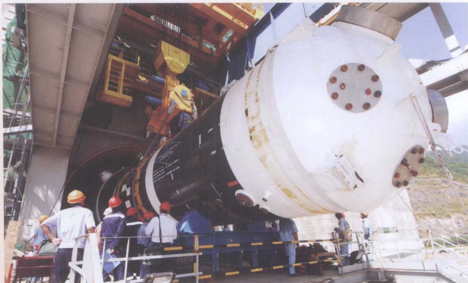
2008年8月29日，用于岭澳核电站二期工程1号机组的我国自主研发制造的首台百万千瓦级核电站蒸汽发生器开始安装
