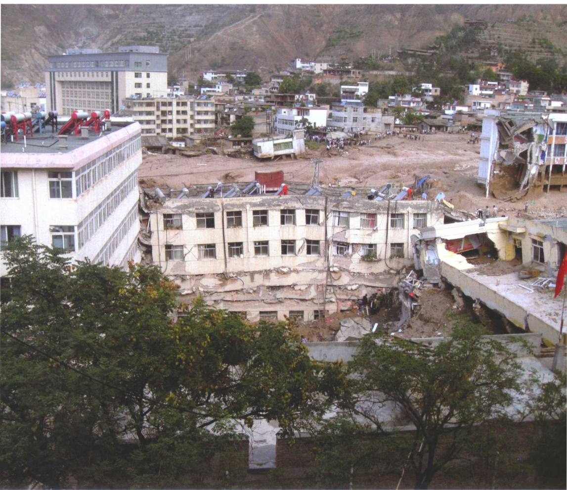
2010年8月8日9时31分摄 被冲塌的城关一小和公安局楼房
