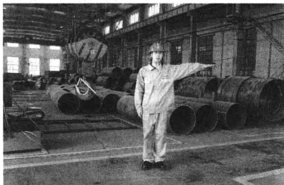
图 1-2-9 吊钩水平移动 4
