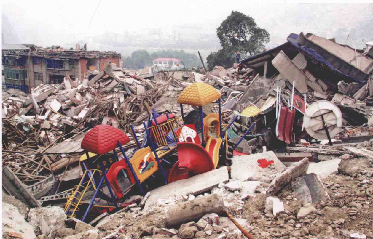
毁于一旦的北川县中心幼儿园
