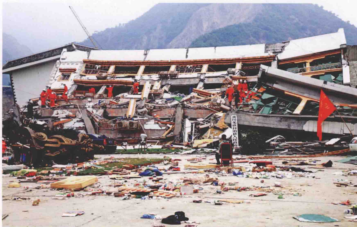
被震毁的北川羌族自治县人民政府大楼
