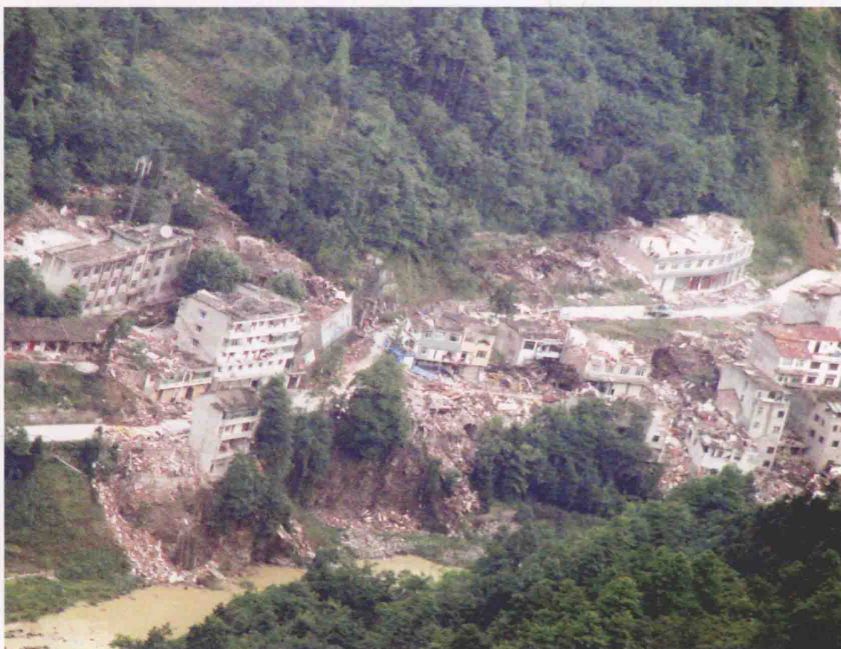
地震中严重受损的安县茶坪乡场镇
