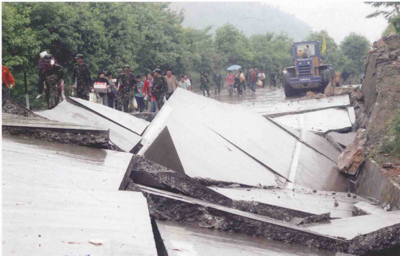
被震毁的公路
