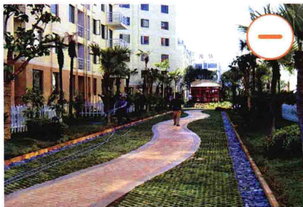
图 1.1-11 植草砖铺设消防车道只有 30%~50% 空隙率，覆盖率差，黄土易裸露，效果难把控。
