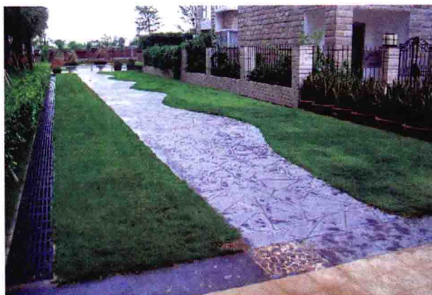
图 1.1-4 隐形消防车道既保证了正常使用消防车道，又改善了平日视觉上的景观效果。
