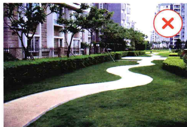
图 1.1-15 过度的隐形带来了识别问题。会使消防车出勤时不能有效识别车道，车轮深陷普通绿地的土壤中而无法前行。
