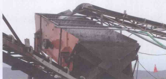
图 3.3.5-2 粗集料水洗装置
