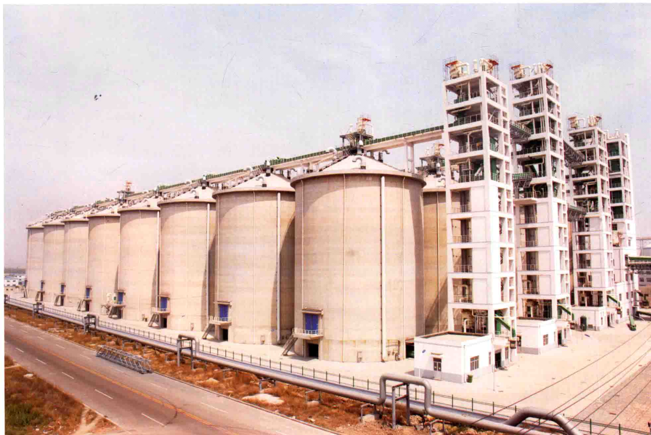
中储粮（天津）仓储物流大豆散粮输送系统MEC工程
