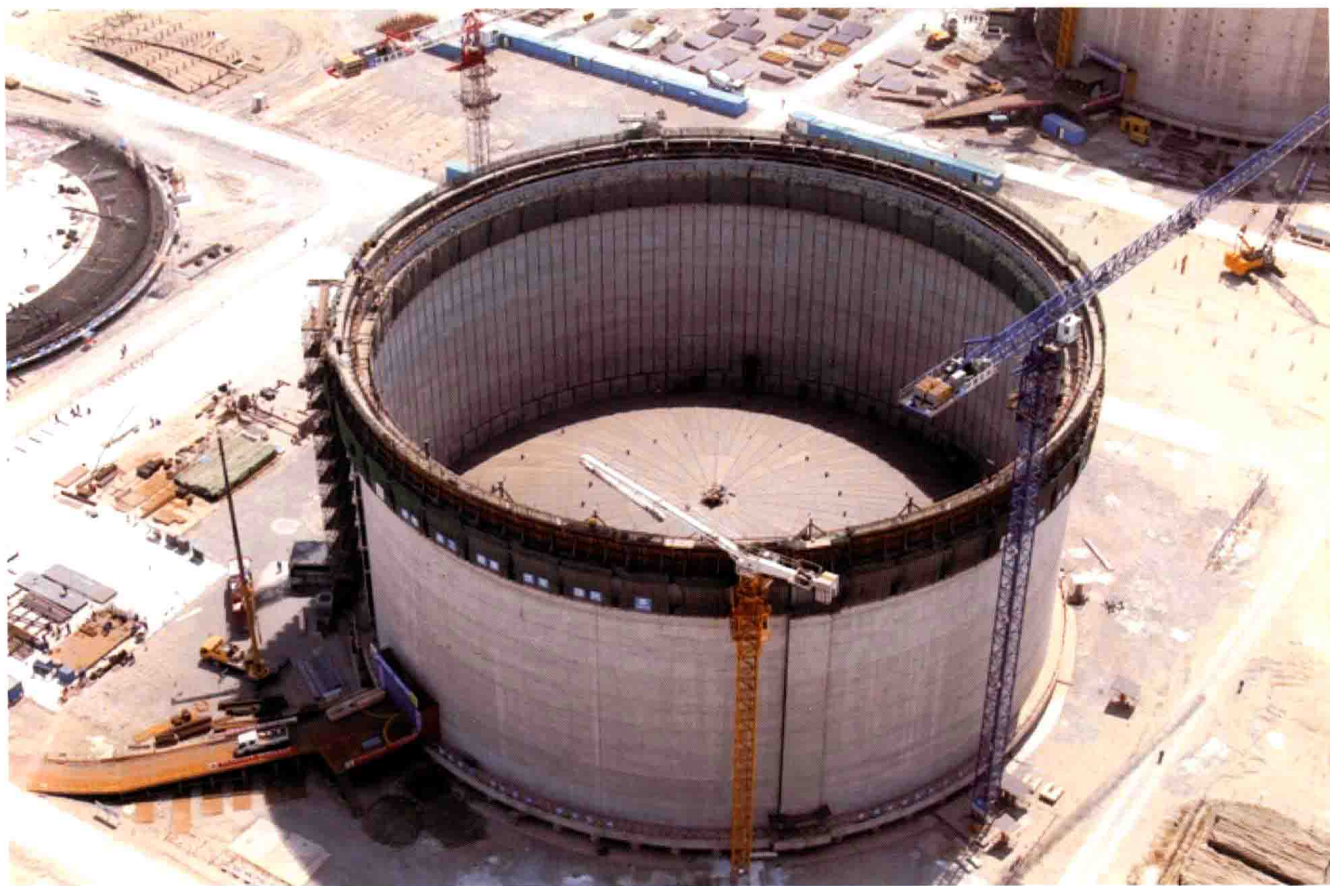
LNG储罐筒体施工技术
