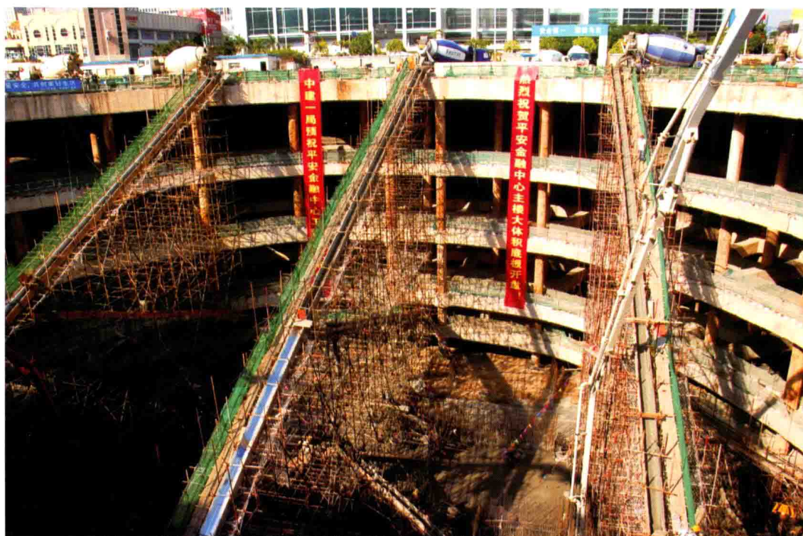
深圳平安金融中心大体积底板混凝土施工技术
