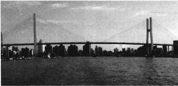
图 1-8 上海南浦大桥
