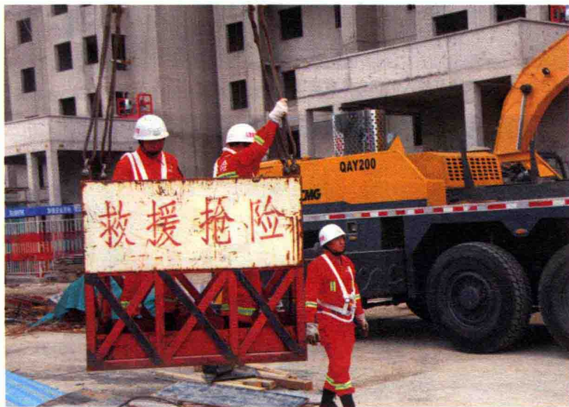
图 3-1 施工现场开展突发事故抢险应急演练
