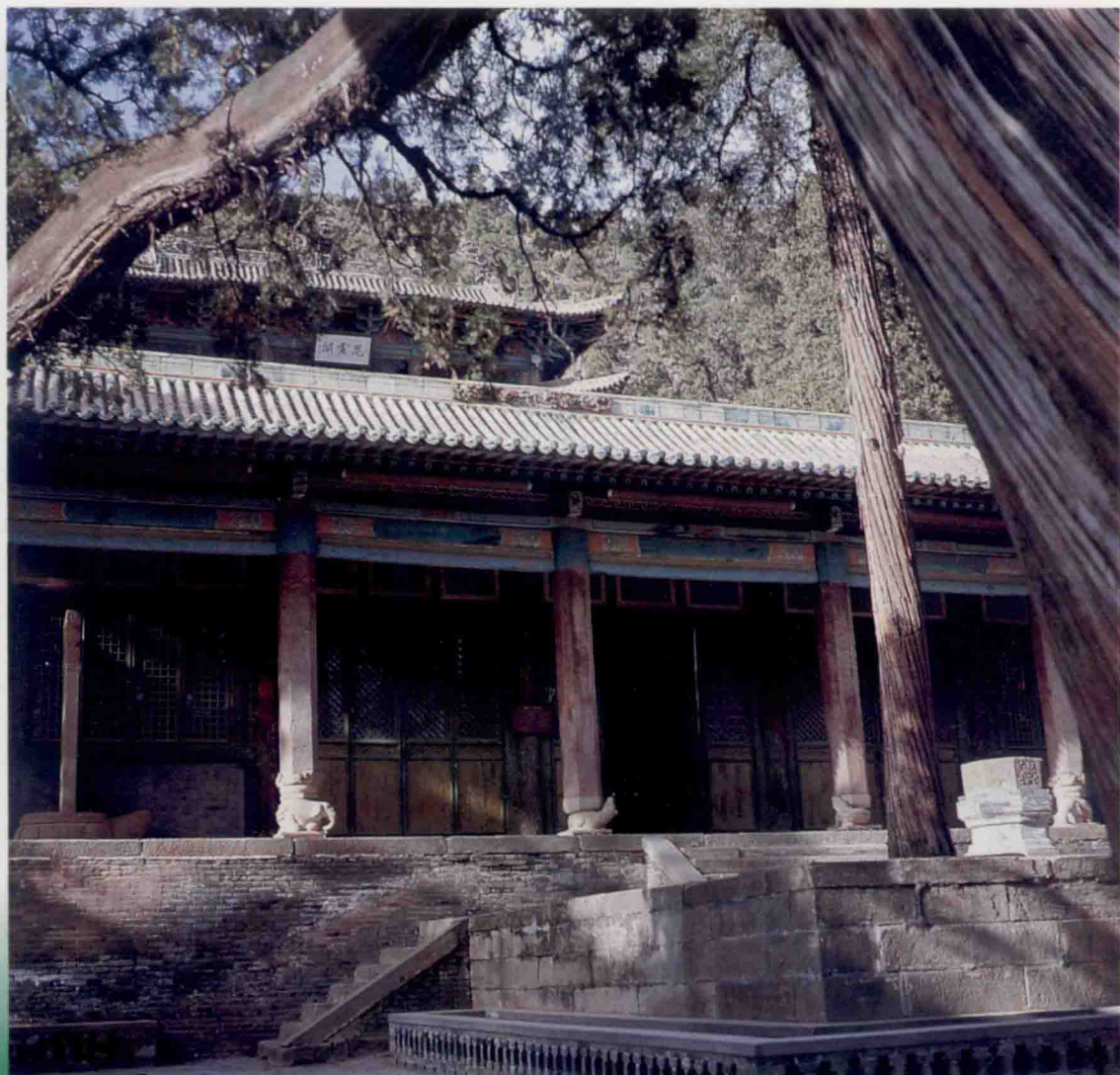
交城卦山天寧寺 交城の掛山天寧寺
