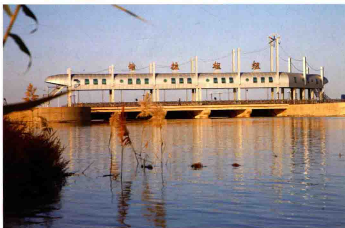
恰拉引水枢纽
