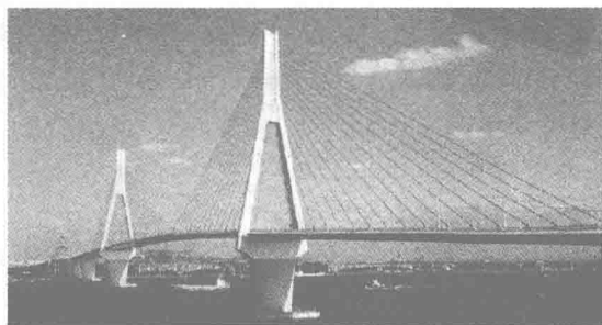
图 1.1.5 组合体系桥(斜拉桥)
