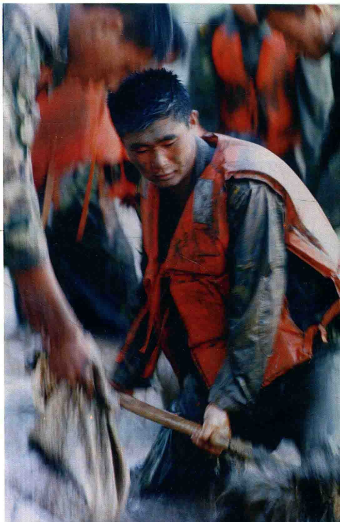
■ 沈阳军区某部在嫩江大堤下泥水中取料 / 冯凯旋 摄
