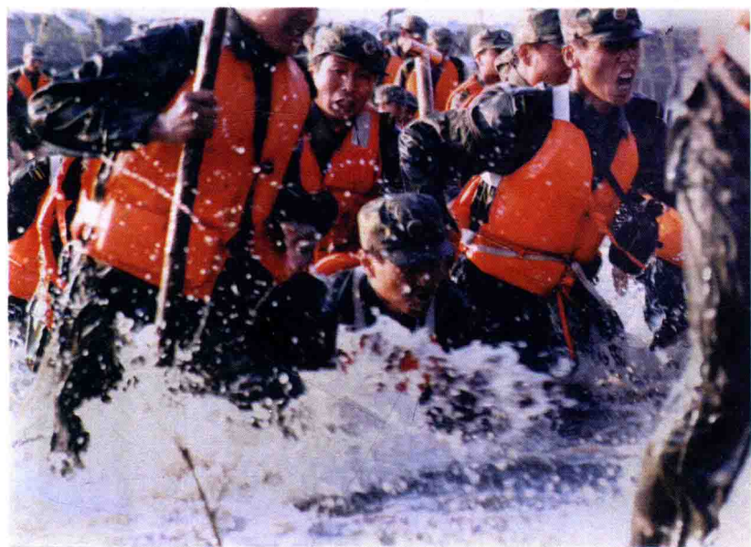
■松花江卡脖子段出现管涌后，官兵们用躯体挡住洪水冲击，垒堰筑坝 / 冯凯旋 摄
