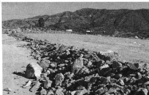
图 1-5 填方路段填层超厚、填料粒径超标
