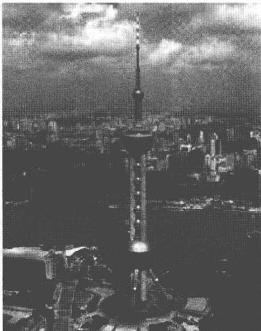
图 1-4 上海东方明珠广播电视塔
