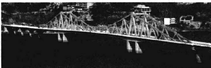
图 1-6 福建水口闽江大桥实景
