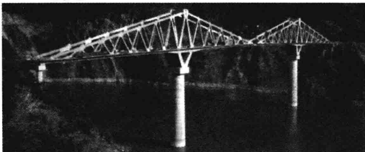
图 1-7 归州大桥全景
