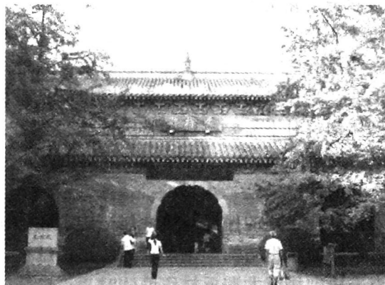
图 0-8 南京灵谷寺无梁殿
