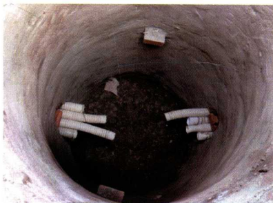
彩图 4 渗水管入井口
