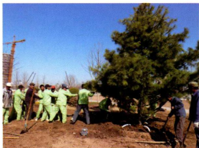
彩图 25 人工拉拽调整苗木垂直度
