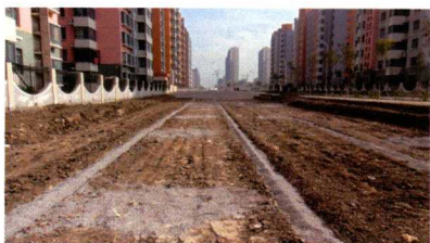
彩图 3 渗水管四周用石屑填盖
