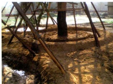
彩图 38 修筑二道灌水围堰
