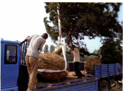
彩图 8 两根吊带吊装法
