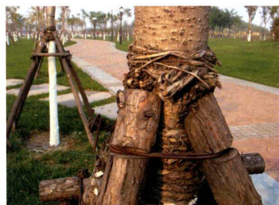
彩图 60 支撑未及时撤除，树皮破损
