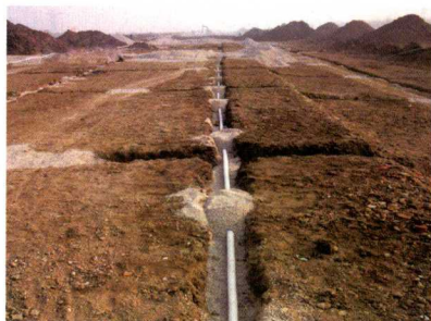
彩图 1 铺渗水管（盲管）
