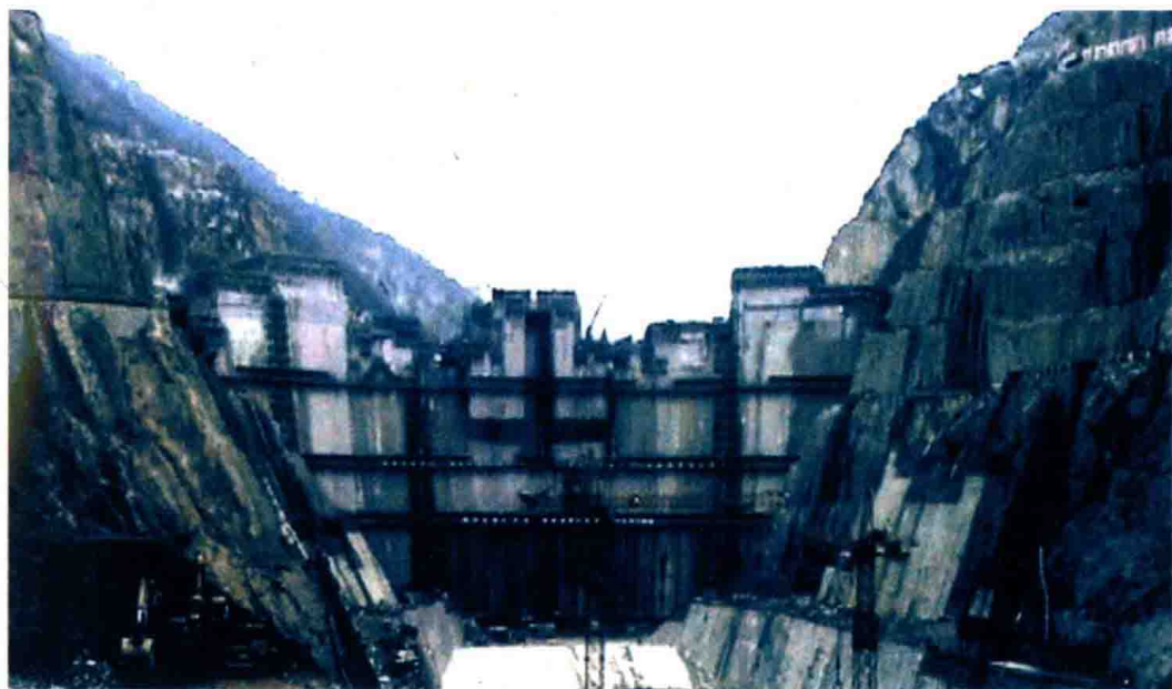
正在修建中的构皮滩水电站
