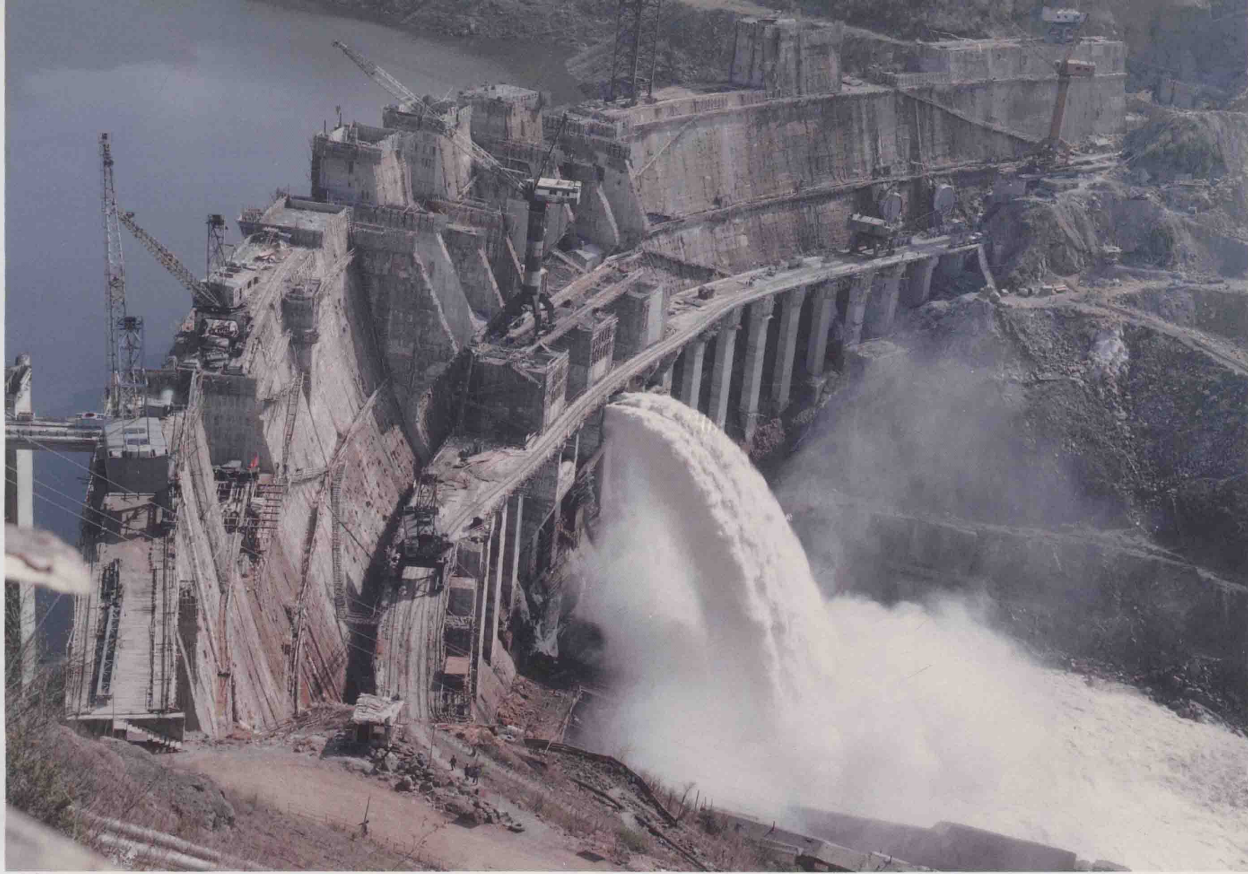
白山水电站全貌。
