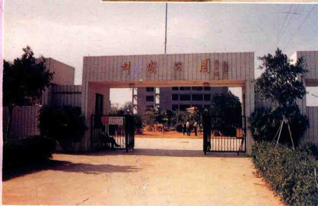
已竣工的蚌湖中心幼儿院
