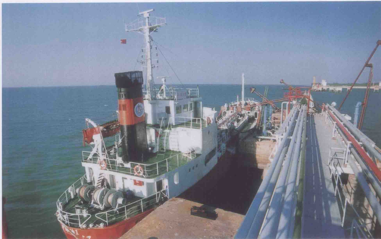
图9 海南省中石化油码头
