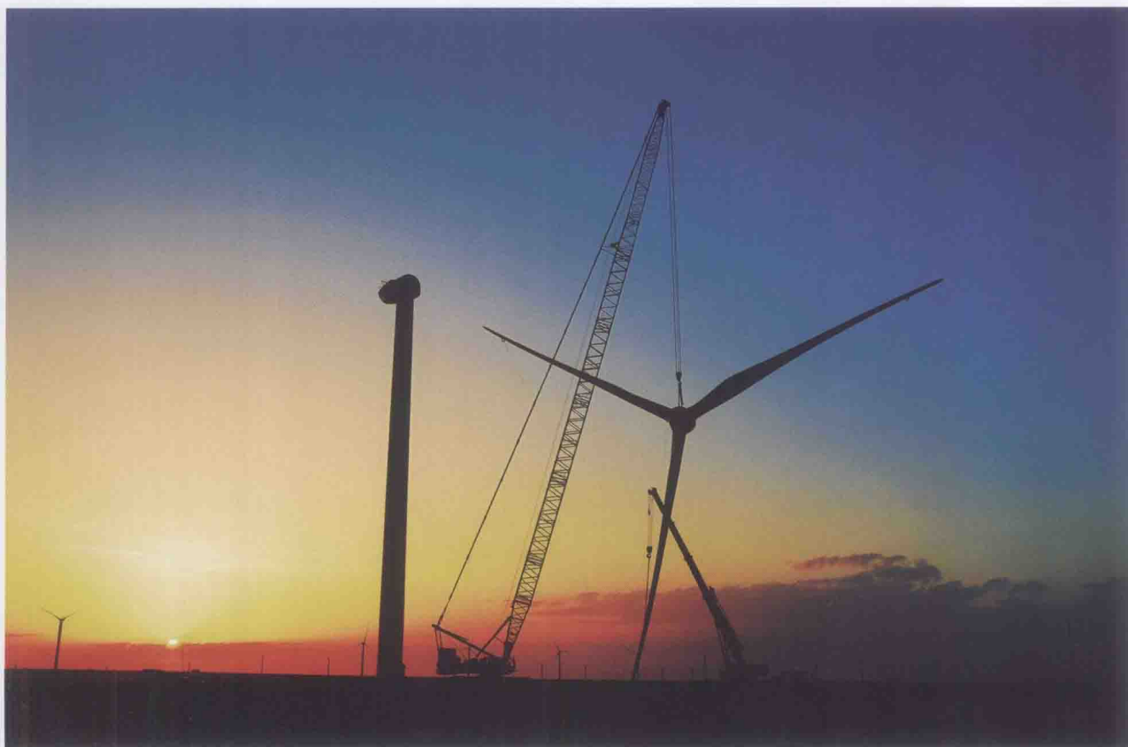
图 8 甘肃省玉门风电场 400 吨塔吊正在吊装风机叶片
