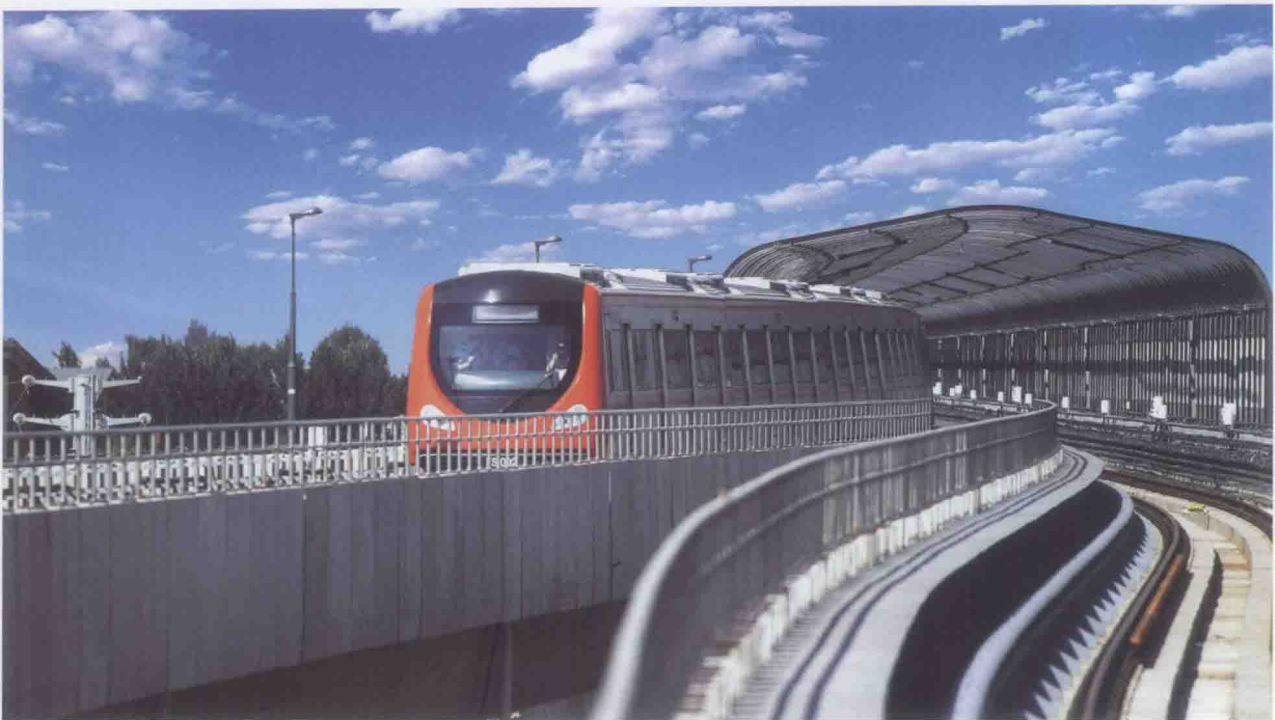
图1 北京市地铁房山线
