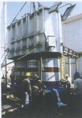
▲对变电站主变进行大修维护
