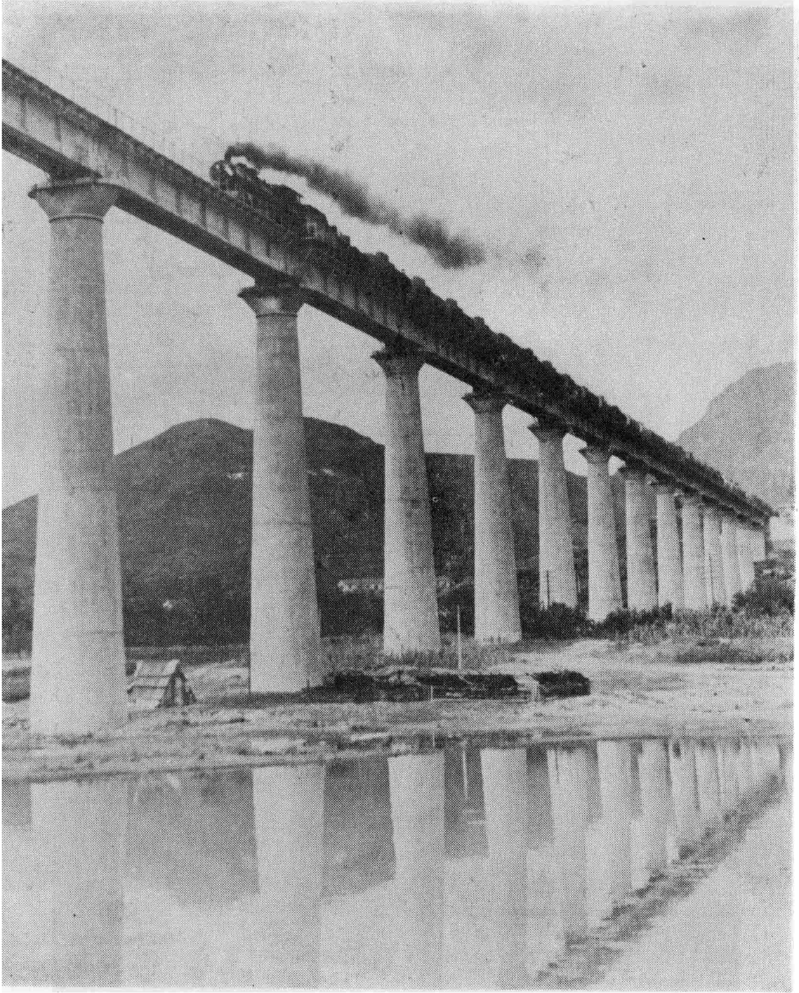
全线最高的特大桥——大石河桥
