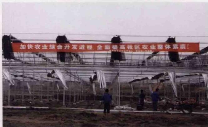
正在施工的国家级农业科技园区花卉大棚
