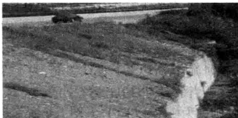
图 1.10 挡土墙实景图
