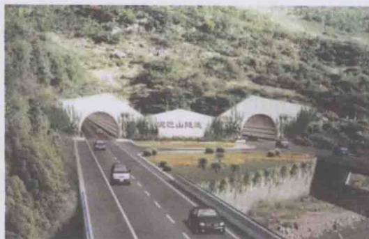
(b) 泥巴山隧道
