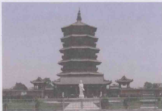
(a) 山西应县木塔 (佛宫寺释迦塔)
