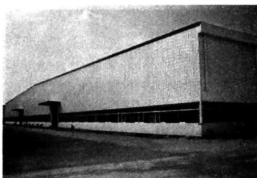
图 1-9 使用中的轻型钢结构厂房
