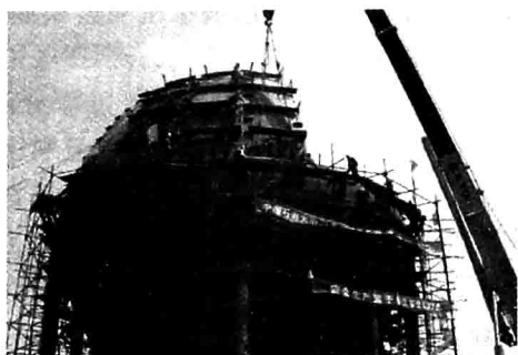
图 1-14 兴建中的油罐
