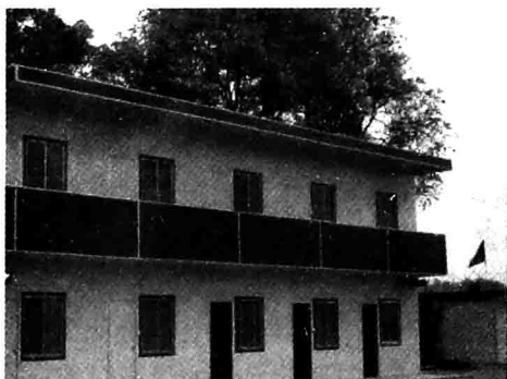
图 1-16 钢结构临时用房
