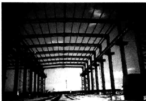
图 1-8 兴建中的轻型钢结构厂房
