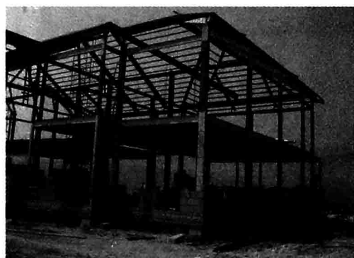
图 1-10 兴建中的轻型钢结构别墅
