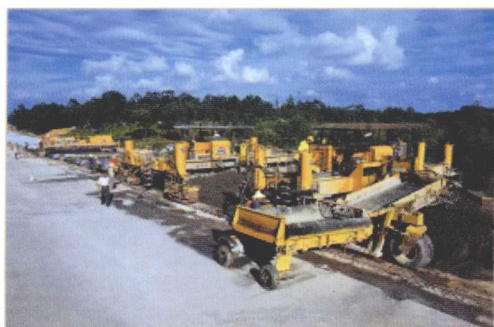
8.5m水泥砼滑模摊铺机组施工
