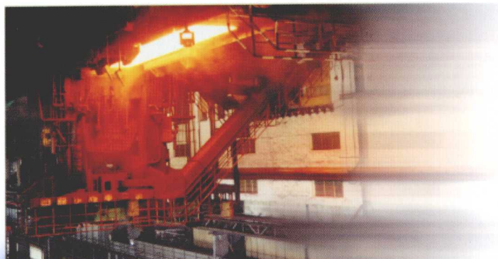
韶钢中板生产线
