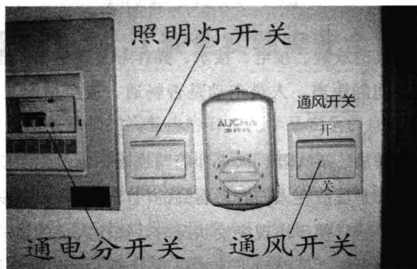
图 1-5 通电分开关、通风开关安装图
