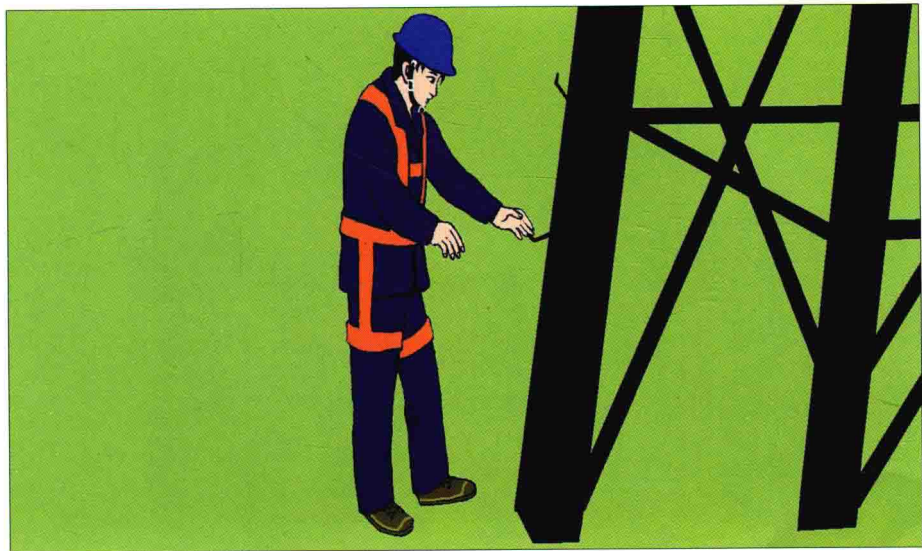
6. 登塔前检查铁塔脚钉。
