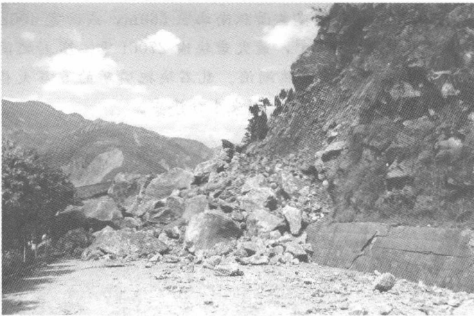
图 1.2 汶川地震引发的公路边坡崩塌
