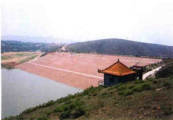
除险加固后的老虎洞水库大坝。
