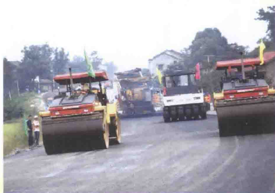
公路改建油路摊铺
