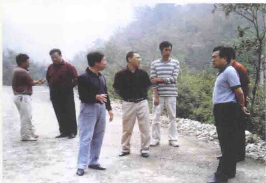
市委书记袁卫东在公路施工现场
