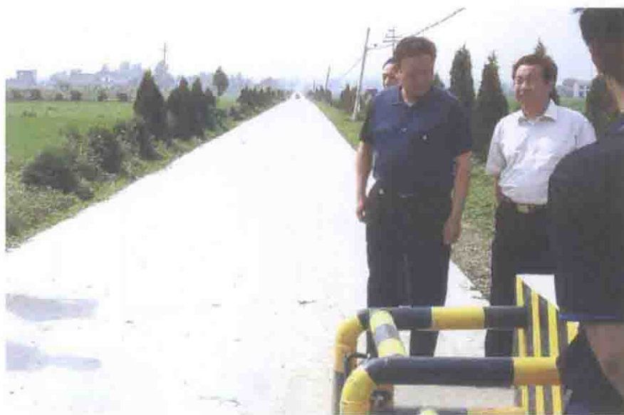
农村公路检查验收
