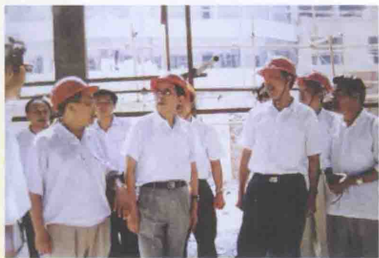
宜昌市政府副市长郑广玉在公路施工现场
