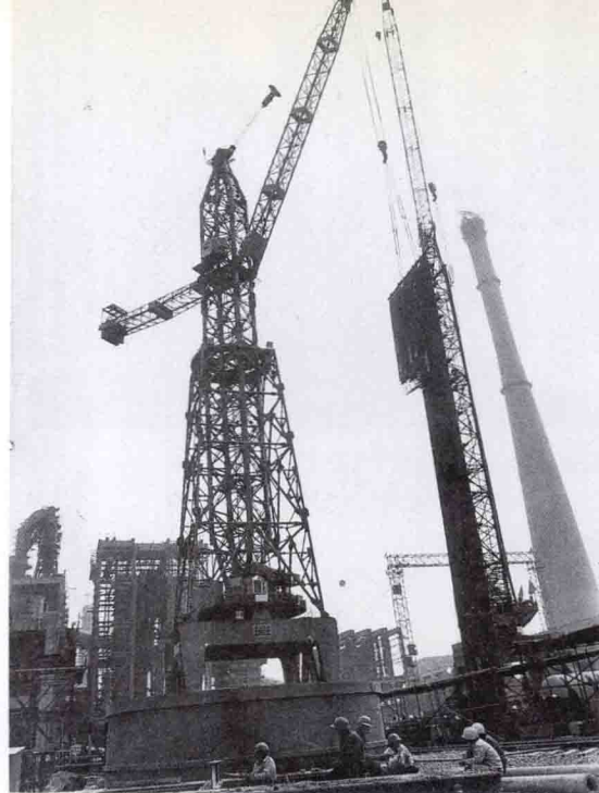
电建工人在吊装水冷壁大件
