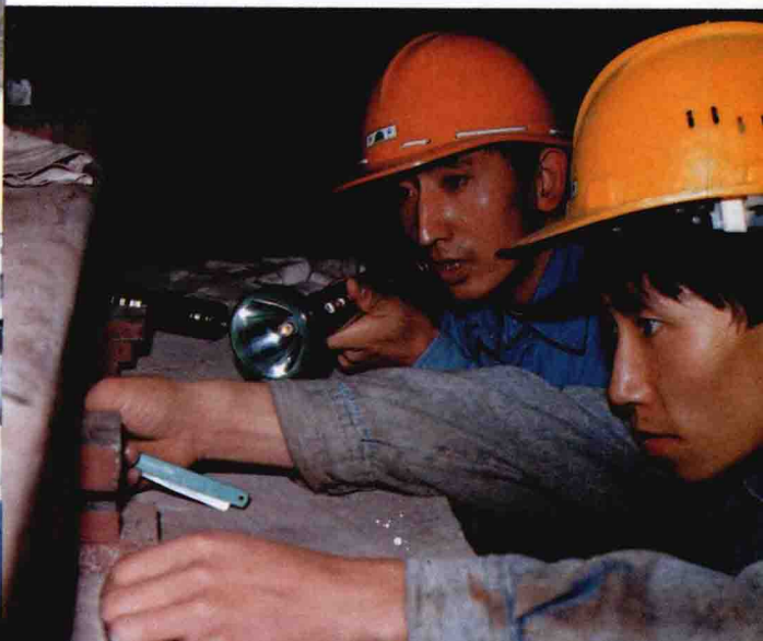
电建一公司工人在大同二电厂建设工地吊装二号 汽轮机转子(左图)和测试汽轮机台板间隙(右图)
