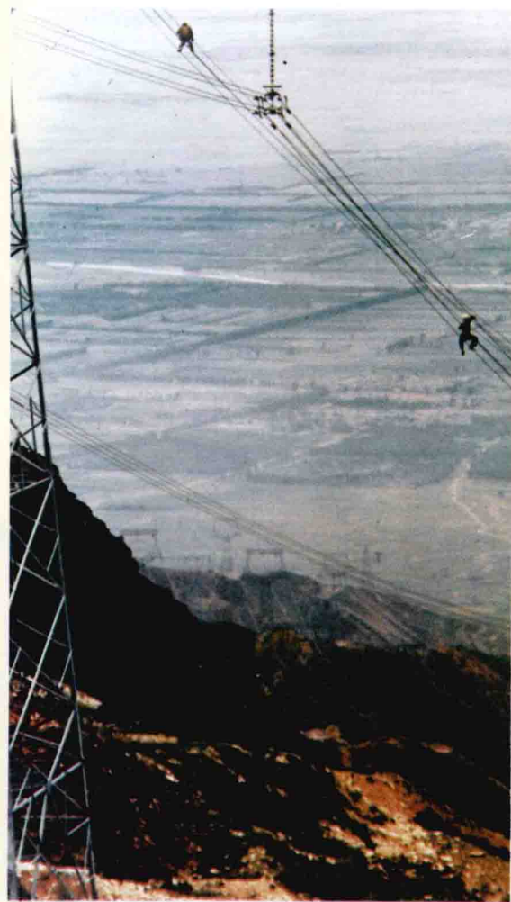
大同——房山 500 千伏超高压输电线路跨过海拔 1900 多米的北岳恒山火烧岭
