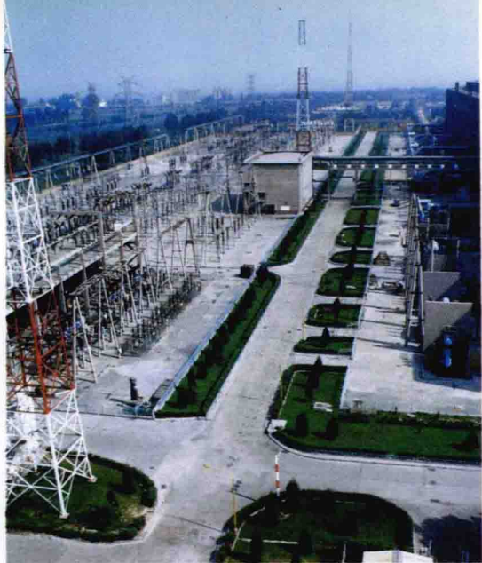
漳泽发电厂厂区
