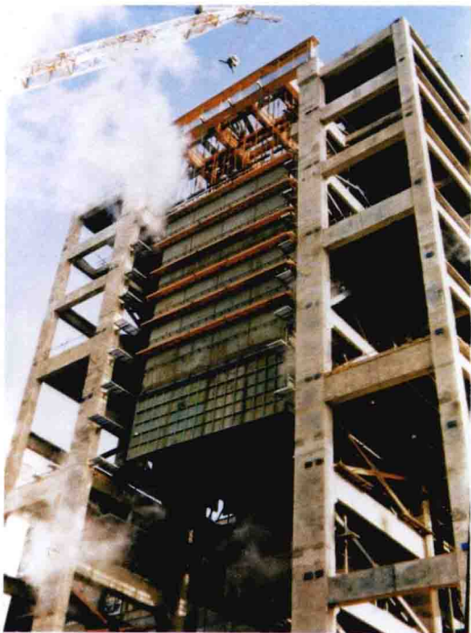
大同二电厂施工现场的锅炉在吊装
