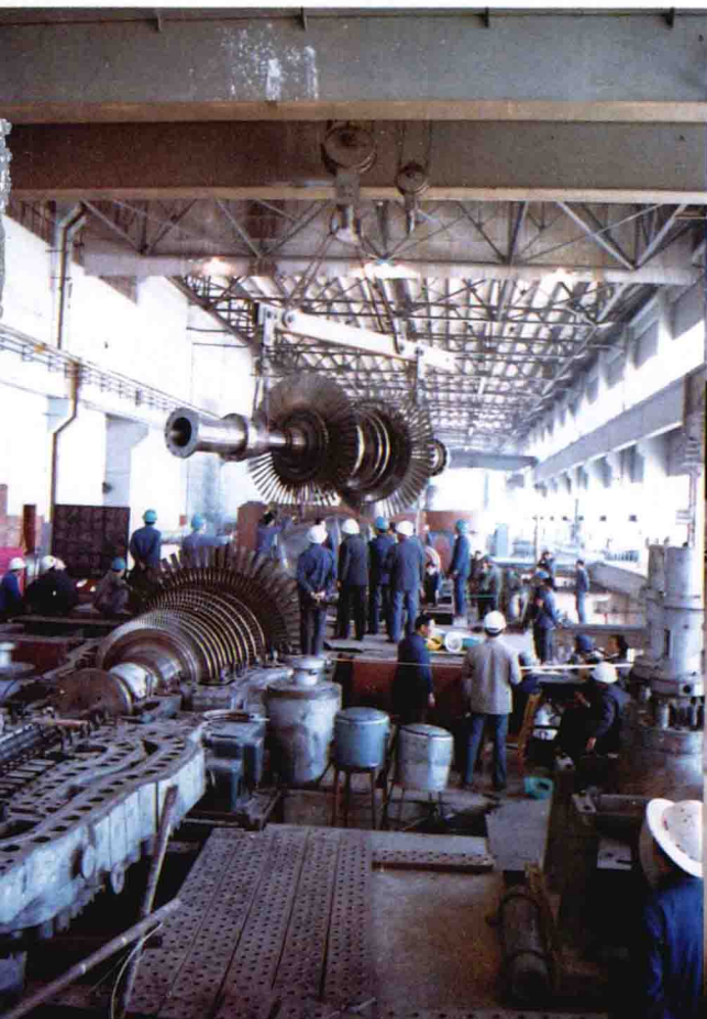
电建一公司工人在大同二电厂建设工地吊装二号 汽轮机转子(左图)和测试汽轮机台板间隙(右图)
