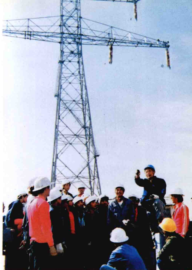
神头至大同 500 千瓦超高压输电线路在架设中
