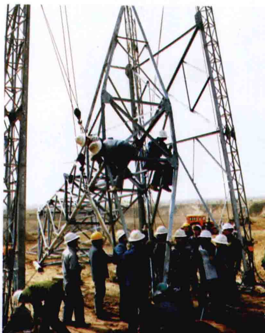
省供电承装公司采用倒装工艺架设神头——平朔 220 千伏输电线路
