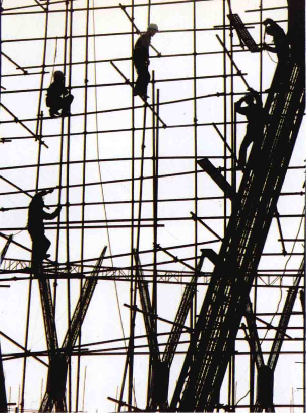
大同二电厂空冷塔施工现场
