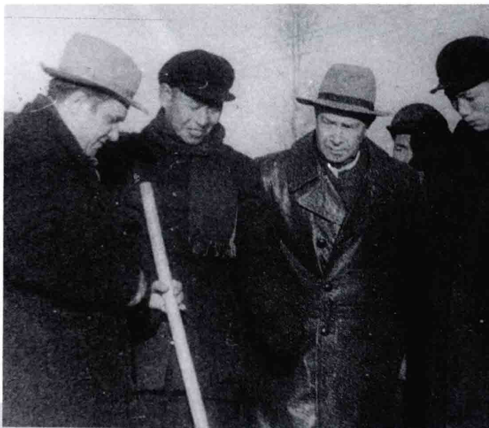
1953年10月24日,由苏联援建的太原第一热电厂一期工程破土动工
