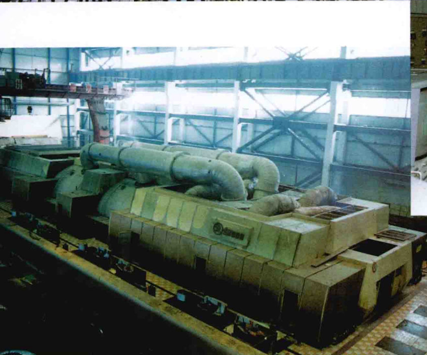
神头二电厂装有 2 \times 50 万千瓦捷制超临界系数汽轮发电机组(中左图)。厂长郭连邦在主控室了解情况(中右图)
