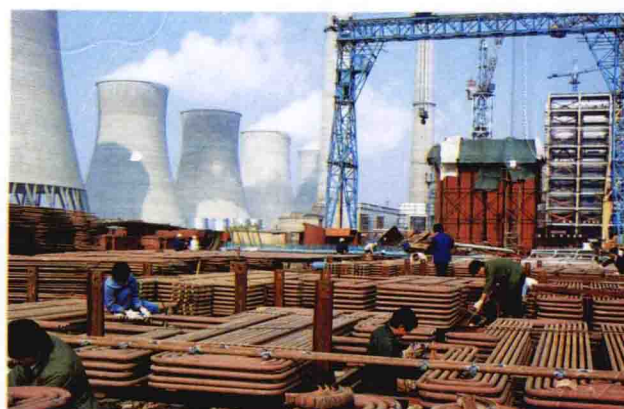
大同二电厂施工现场锅炉组合场
