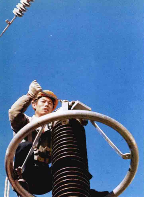
电建工人在安装升压站开关
