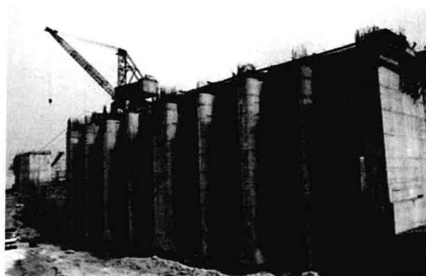
施工中的闸墩
