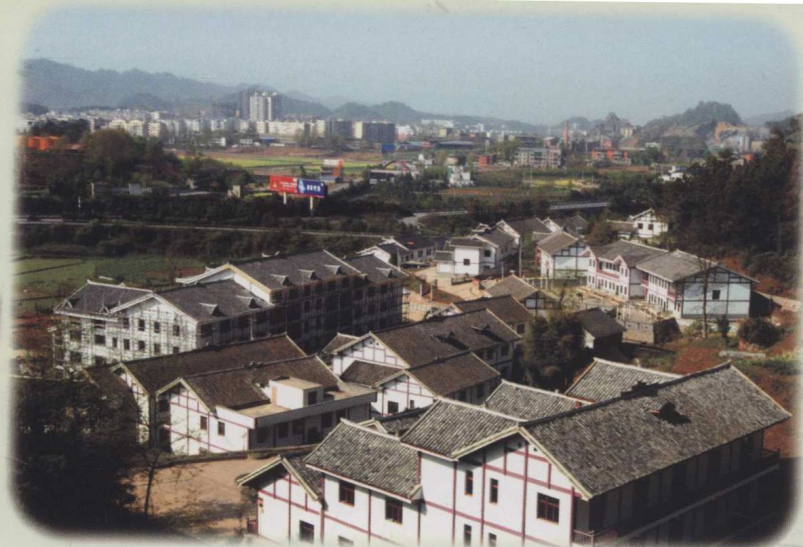
王五桩新农村建设示范点
