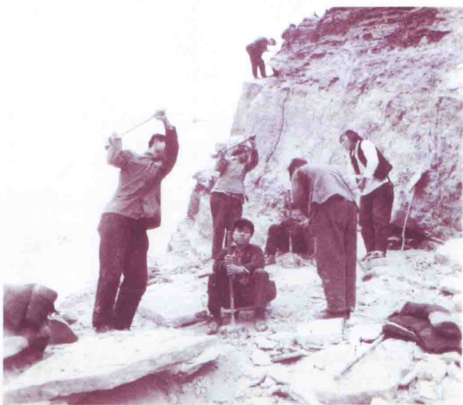
1966年，幸福渠工地“郑献青英雄排”的炮手们劈山炸石施工一角。(宜都市档案馆提供)
