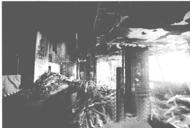
图1-3 事故后被烧毁的大楼
