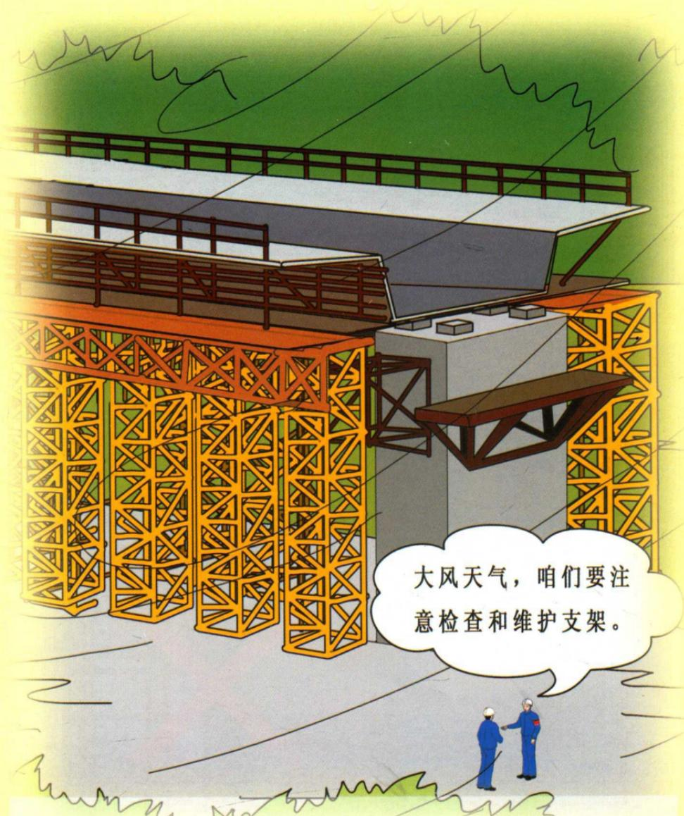
模板、支(拱)架安装后、使用中、拆除前及遇异常天气时，应对其进行检查和维护，当发现沉落、变形、跑模等情况时，必须立即停止施工，并经整修加固安全后方可复工。
