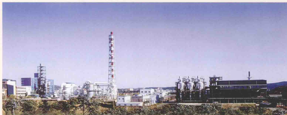
云天化集团化肥产业磷肥生产基地 —— 云天化国际富瑞分公司
