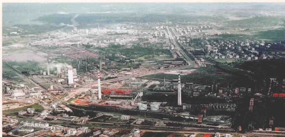
云南煤化集团曲靖煤化工基地
