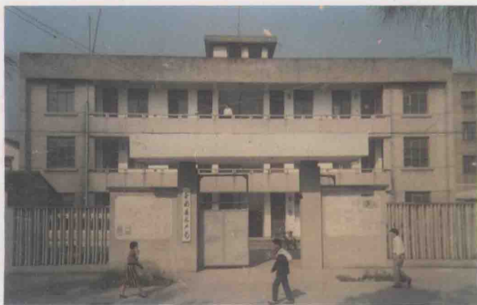
苍南县 水产局 办公楼
