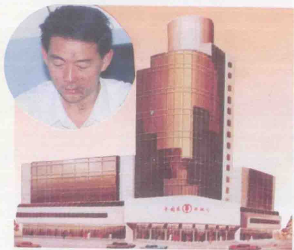
枝城市农业银行营业大楼由丰家店建筑公司承建，左图为模型图，左上角为市农业银行行长陈先树。
