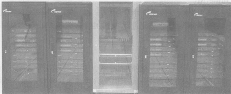
图 1-1 安装交换机设备进入机柜
