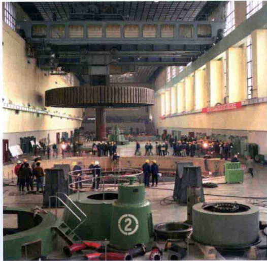
发电机转子吊装
