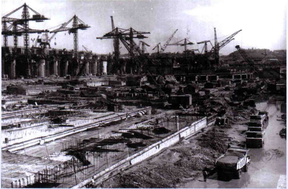
二江泄水闸消力池护坦混凝土施工
