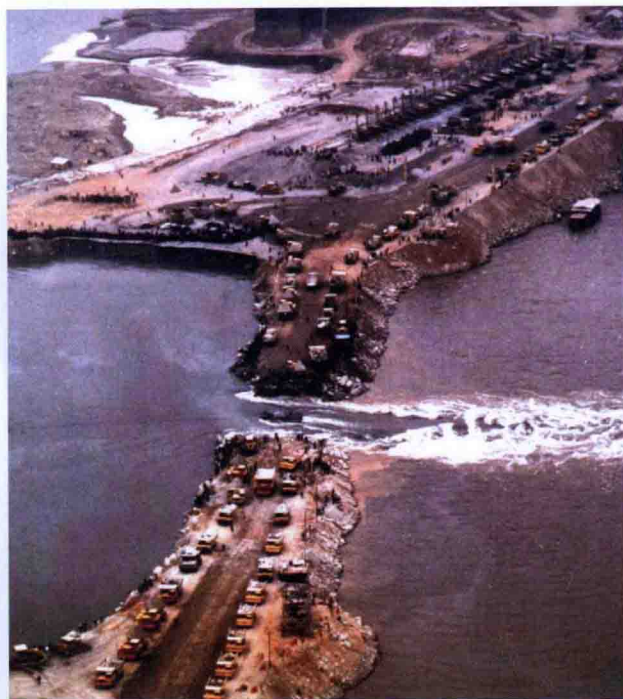
大江截流龙口合龙施工
