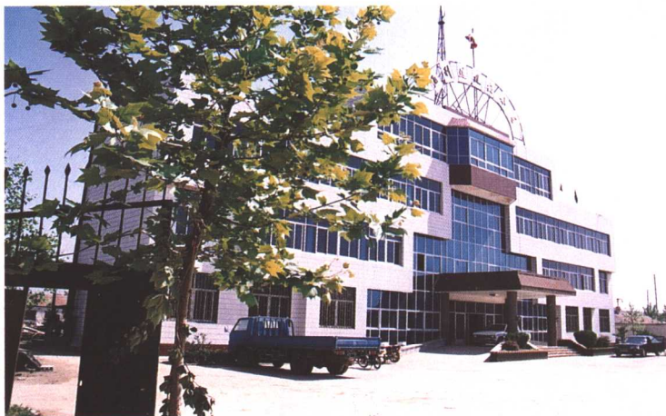
通利达建安公司办公楼
