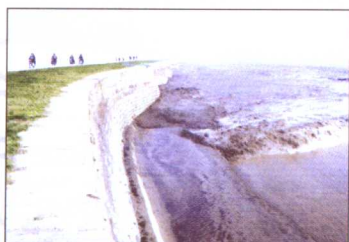
重修老鱼鳞石塘，加固基础，加高加宽塘身，完善护面，提高了抗御洪潮的能力
