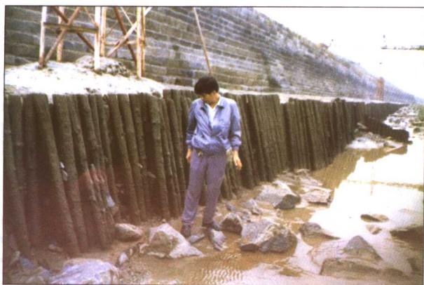
海塘前的第二道护坦冲失后，长约4m的头坦排桩出露1.5m左右，海塘岌岌可危
