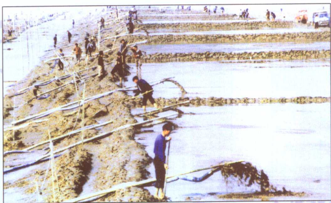
20 世纪 80 年代开始，大规模采用水力冲填筑堤，提高了质量，节省了劳力
