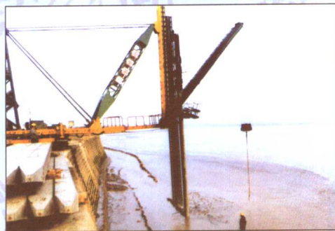
专门设计研制适用于涌潮河段的打桩机，解决了塘基防冲结构不能深筑的老大难问题
