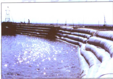
用土工布充泥袋修筑围堰和土堤的临时护坡，显著改善施工条件，提高施工期的安全度
