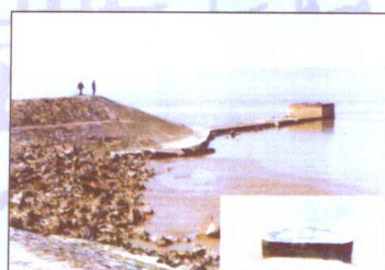
整体深埋的圬工沉井，保护丁坝坝头
