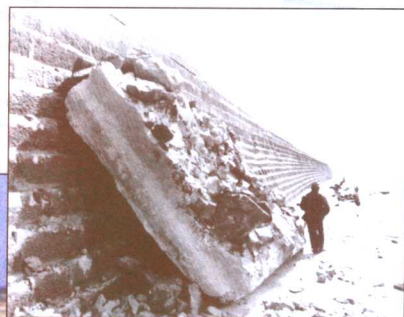
海塘前的第二道护坦冲失后，长约4m的头坦排桩出露1.5m左右，海塘岌岌可危
