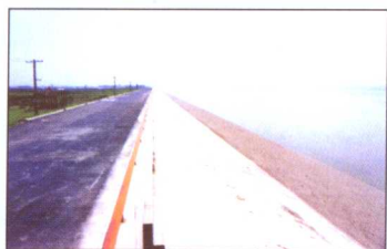
由围堤改建加固后的斜坡式海塘，已是河口段的主要堤塘
