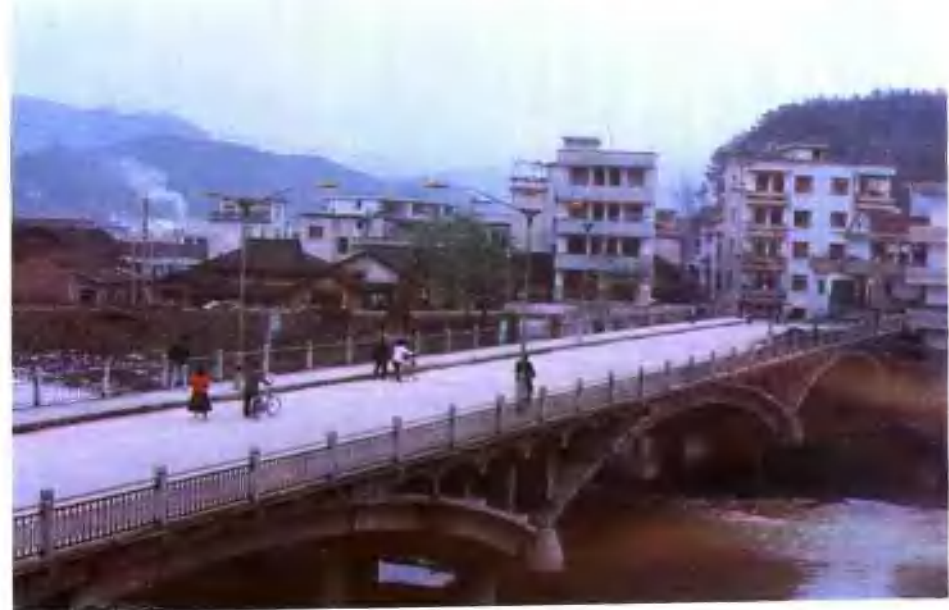
妙高镇叶坦大桥
