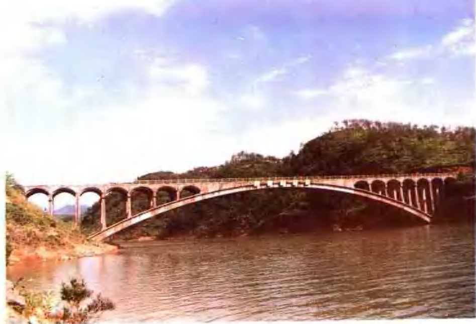
湖赤公路龙潭大桥
